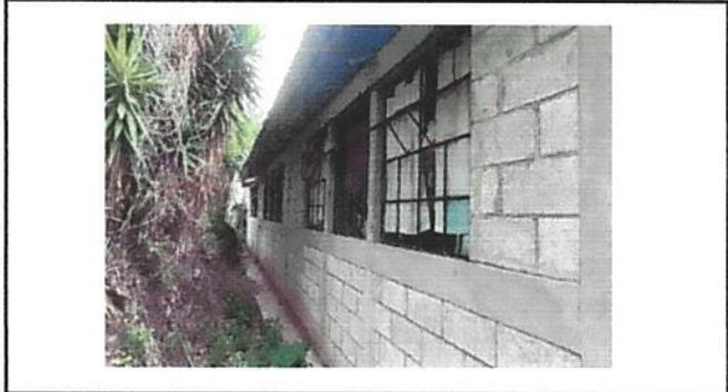
FOTO 1: SUMINISTRO E INSTALACION DE VENTANAS
