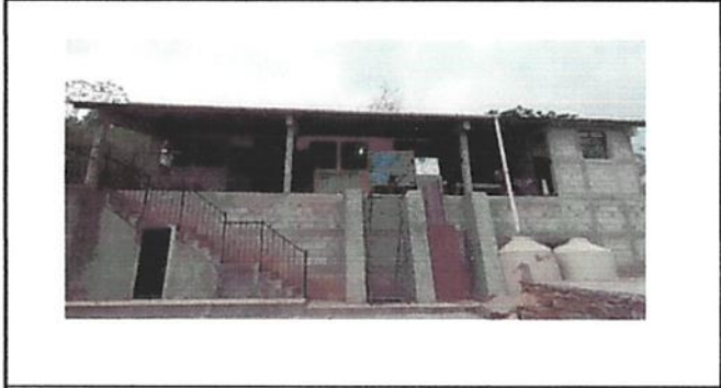
FOTO 4: PINTURA DE MUROS EXTERIORES
