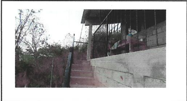
FOTO 2: SUMINISTRO E INSTALACION DE PUERTA
