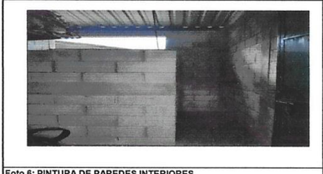
Foto 6: PINTURA DE PAREDES INTERIORES
